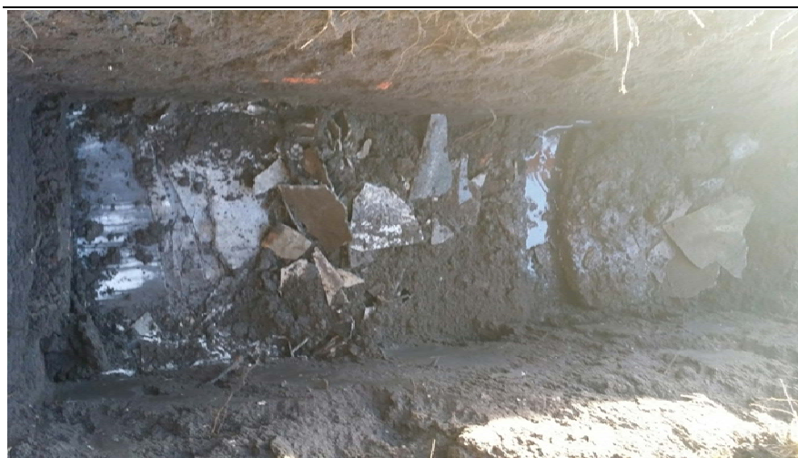
Foto 4.2 Asbesthoudend plaatmateriaal in sleuf 301 (idem in sleuf 302)
